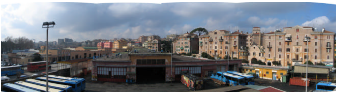
Vista lato est dal cortile interno
