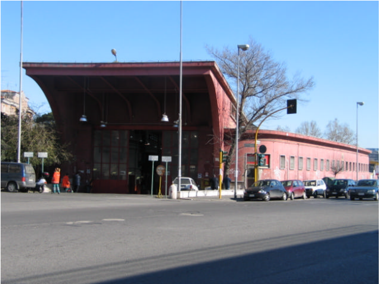
Vista lato ovest – La pensilina
